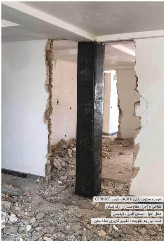
تقویت ستون بتنی با الیاف کربن CFRP300
