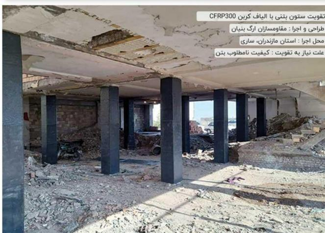
تقویت ستون بتنی با الیاف کربن CFRP300
