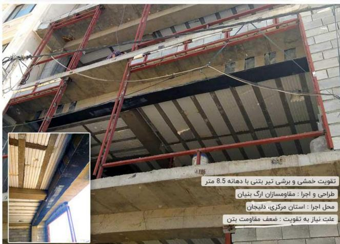
تقویت خمشی و برشی تیر بتنی با دهانه 8.5 متر
