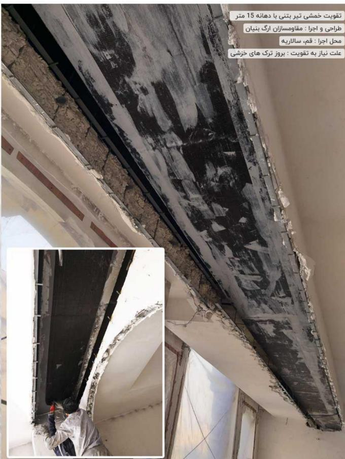
تقویت خمشی تیر بتنی با دهانه 15 متر
