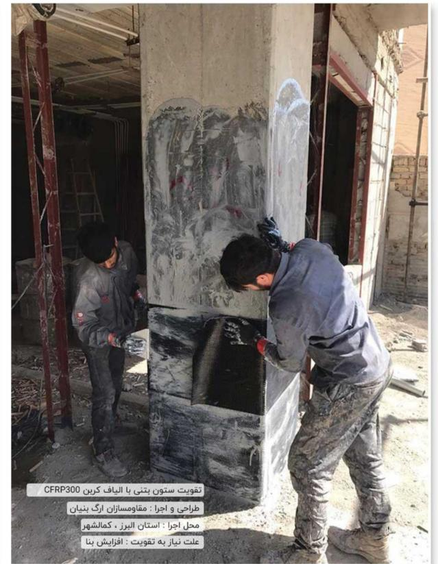
تقویت ستون بتنی با الیاف کربن CFRP300
